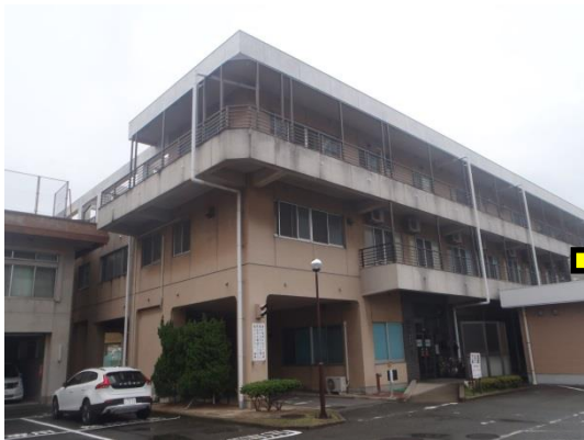
改修工事前（療護棟北西側）
