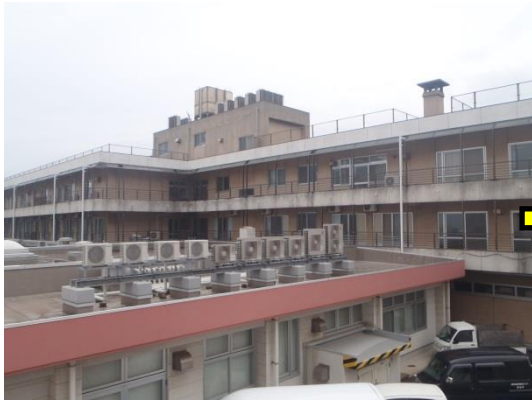
改修工事前（療護棟南西側）
