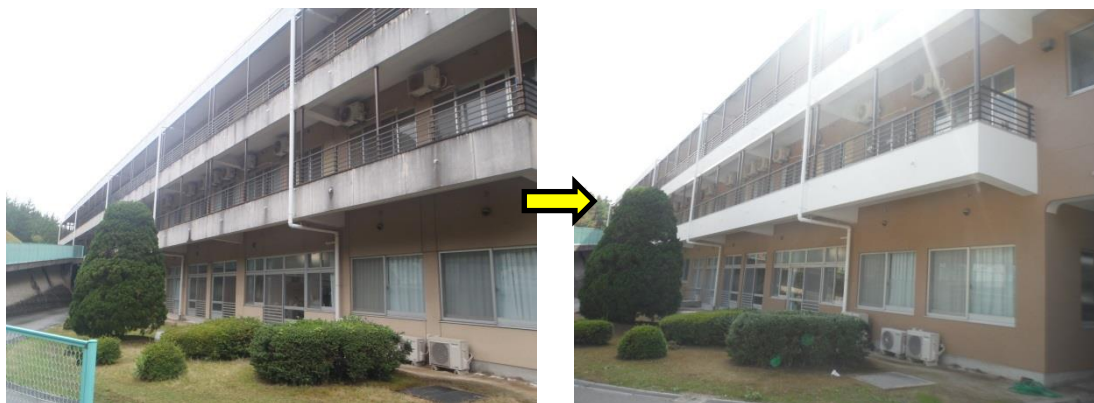
改修工事前 (療護棟北東側)
